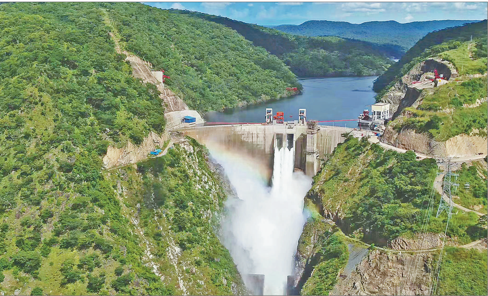
位于刚果(金)卢阿拉巴河下游的布桑加水电站,由中国中铁资源集团投资建设并运营。水电站总装机容量240兆瓦,自2021年11月底运行以来,有效缓解了该国电力短缺,积极促进了当地经济社会发展。图为布桑加水电站正在泄洪。
